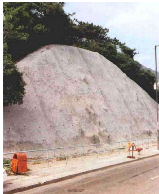
(b) impermeabilização com concreto projetado
