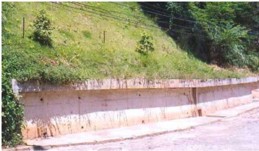
Figura 9. Muro de flexão
