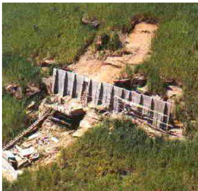
Figura 10. Muro com contraforte
