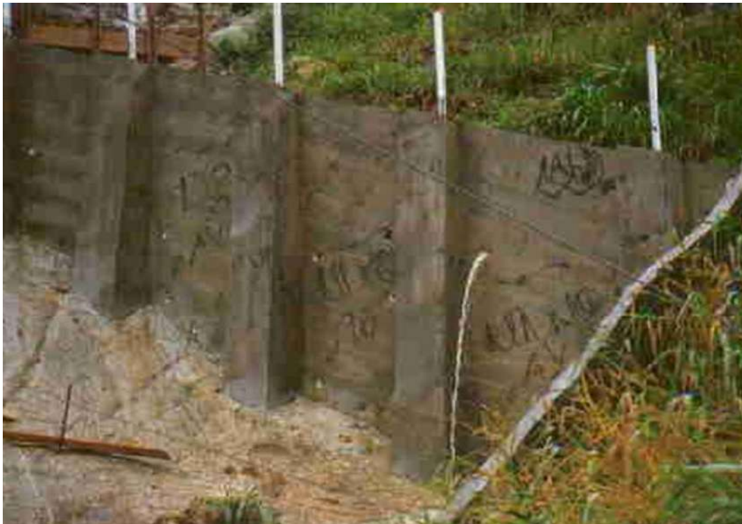
Figura 17. Drenagem de muro com barbaças
