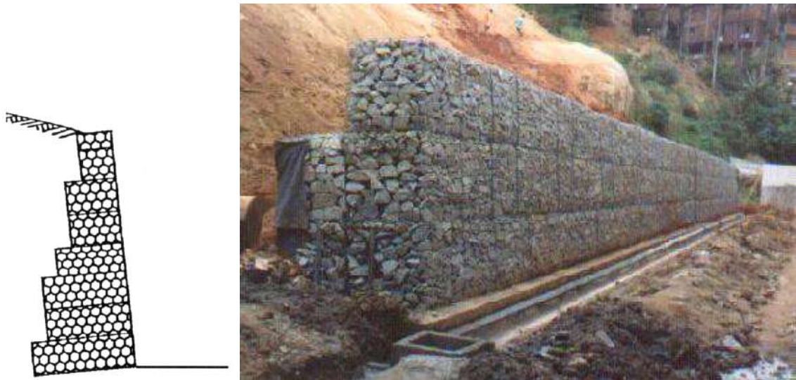
Figura 4. Muro Gabião
