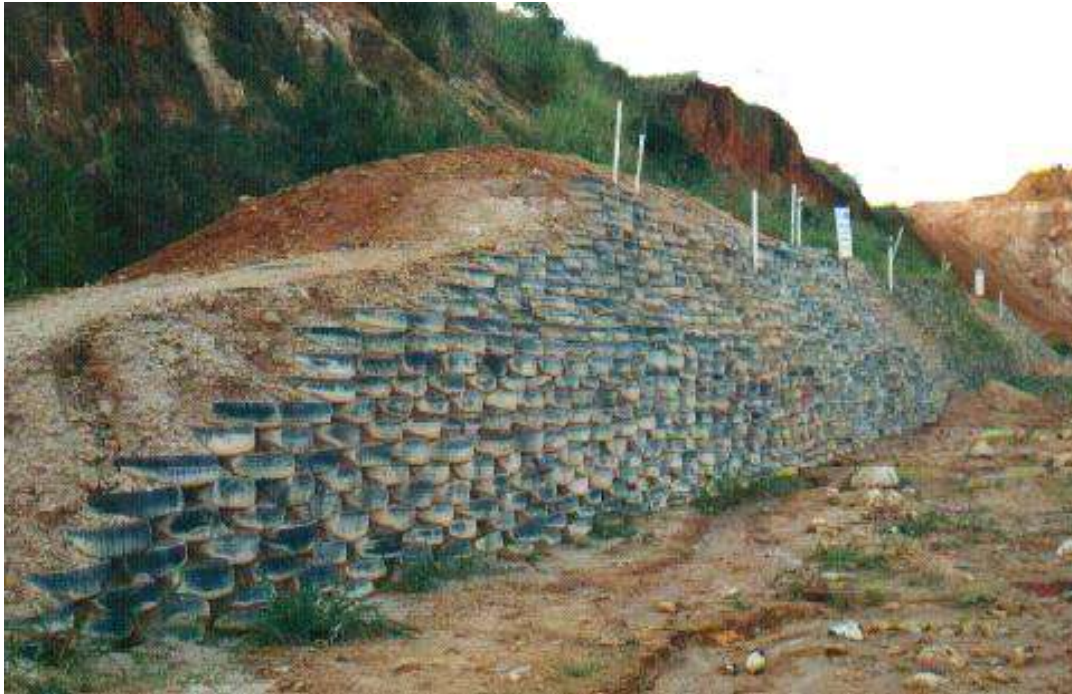
Figura 8 Muro de pneus
