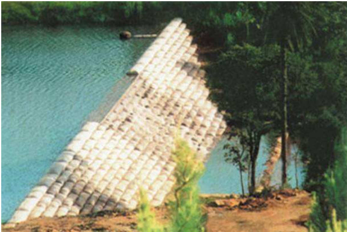
Figura 7. Ilustração de muro com sacos de solo-cimento
